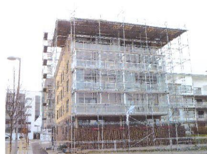
Februari 2016. Nu återstår de vita Minerit-plåtorna.
